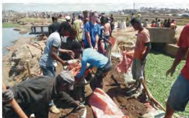
Chantier de solidarité. Ruelle à Andramiarana
